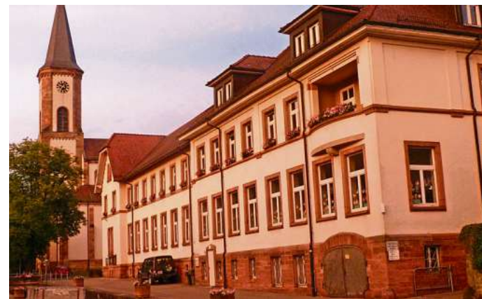
Die alte Reichenbacher Schule wird zur Kita umgebaut. Foto: Vögele
